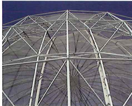
Detalle del nudo de una estructura geodésica.
