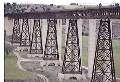
Viaducto del Hacho, en Granada.
