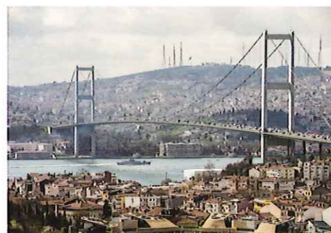
Puente colgante de catenaria.
